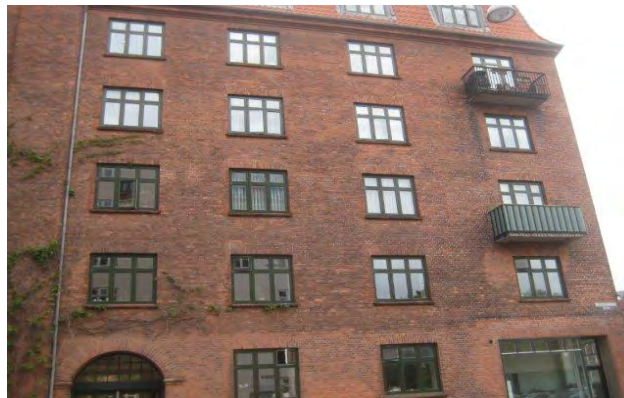
Nye vinduer og altandøre i gadefacade
