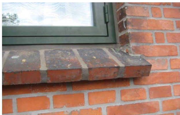
Elastisk fuge omkring vindue - korrekt tilbagetrukket ved alu
