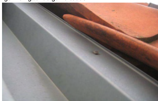
Forkert fastgørelse af dækkapsel mod zinkflunker
