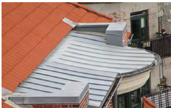
"Fladt" zinktag udskiftet ved Artillerivej. Øvrige holdes Under observation
