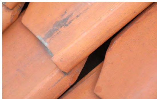
Tegl "trukket" ved oplægning
