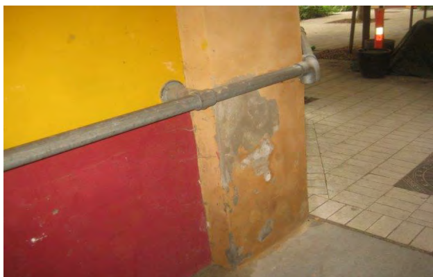
Pudsafskalning. Indfarvet mørtel på cementpuds
