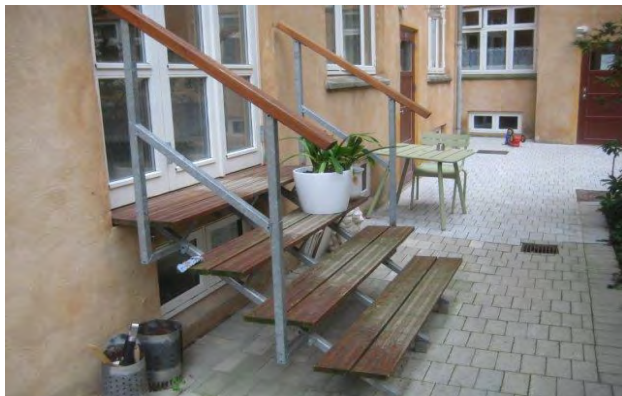
Udvendig trappe til bolige med værn
