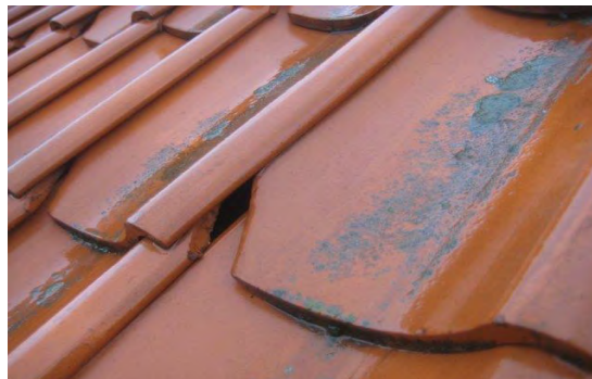
Tagsten "trukket" ved oplægning
