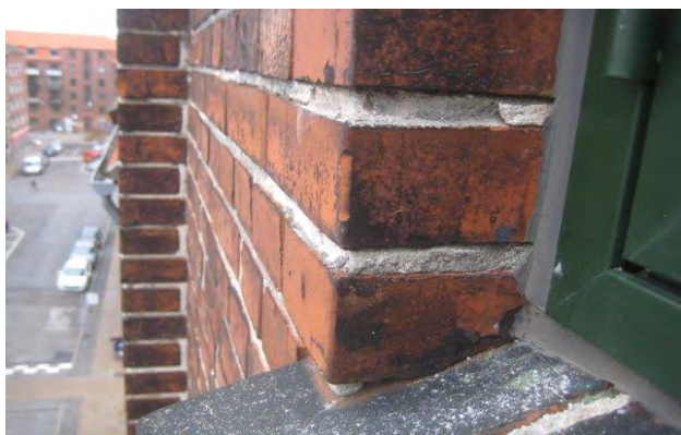
Elastisk fuge omkring vindue - ingen bemærkninger
