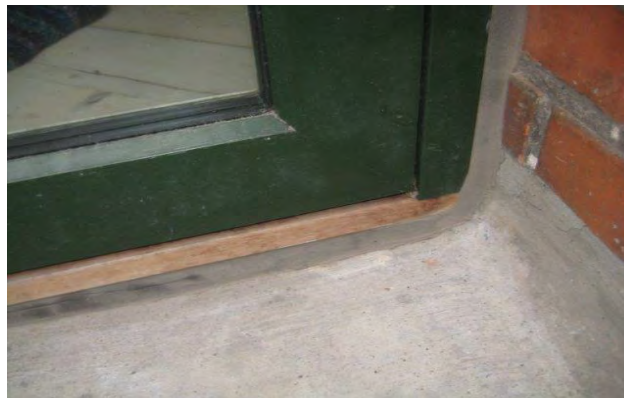
Elastisk fuge omkring altandør - ingen bemærkninger
