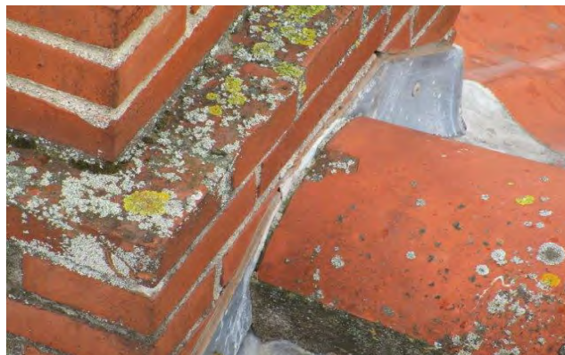
Ved eftergang lukkes med mørtel mod skorsten
