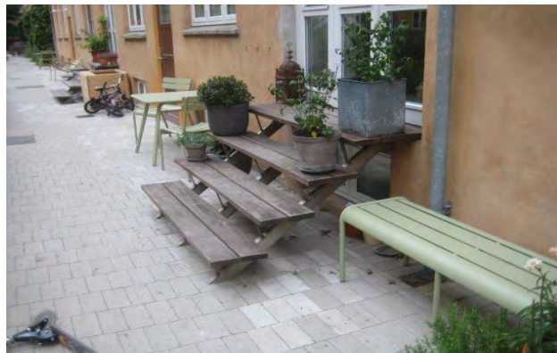
Udvendig trappe til bolig uden værn
