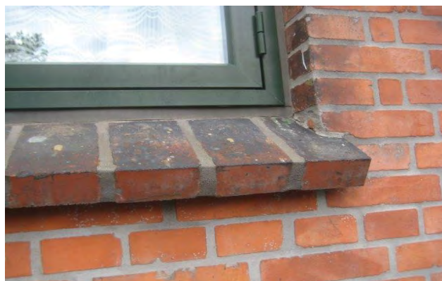
Omfuget sålbænk (rulleskifte) på gadefacade
