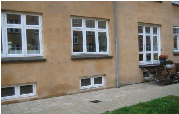
Nye vinduer i gårdfacade
