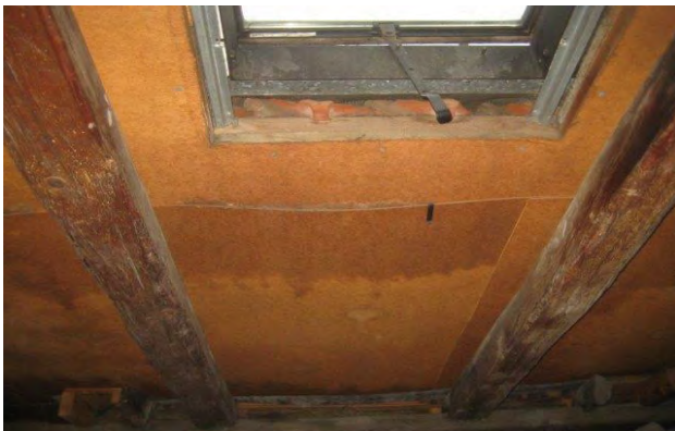
Opfugtet undertag under ovenlys
