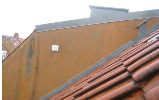
For korte inddækninger ved trappetårne gårdfacade
