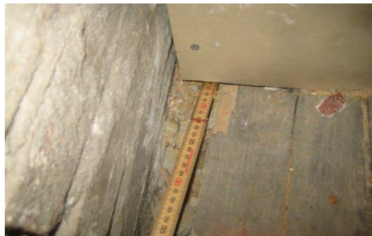
Skillevæg ved tagbolig er umiddelbart tilsluttet direkte på gennemgående gulvbrædder.
